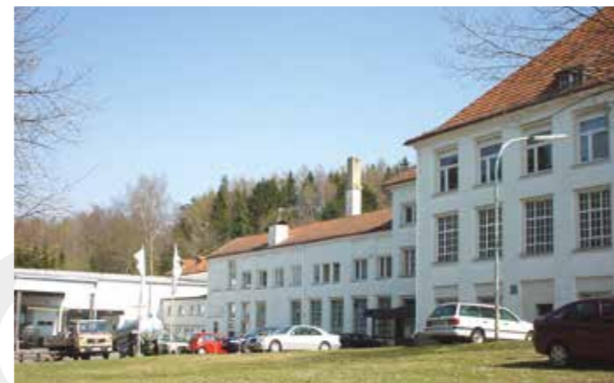
FAN Separator GmbH, Marktschorgast, Germany
